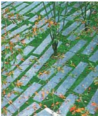
Hovedstier og stræder er både faste og grønne. Flise belægning m. grønt imellem. Stier i det rekreative grønne område er grusstier.
