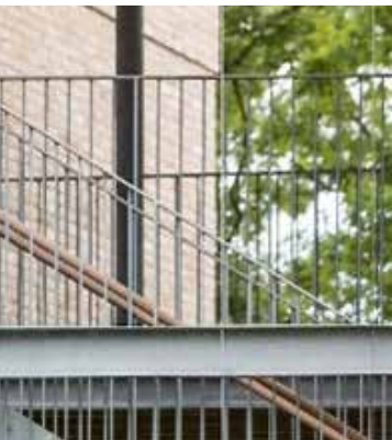
Trapper og svalegange i galvaniseret stål
