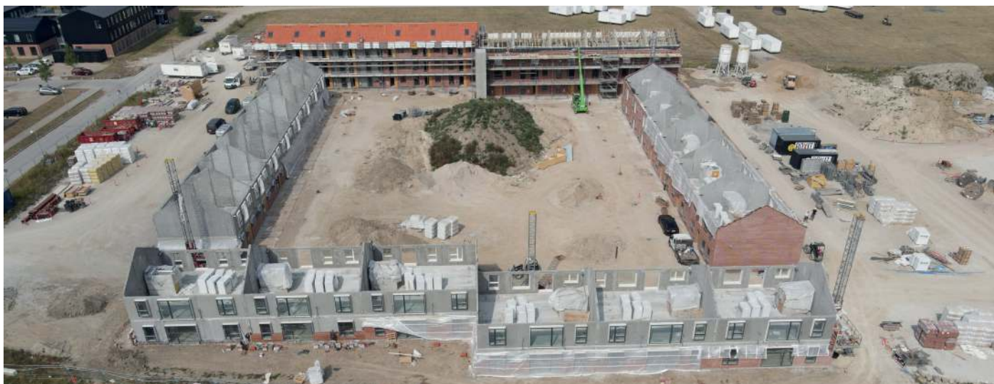
LB Entreprenør har stået for jord- og kloakarbejde i Kasernebyen.
